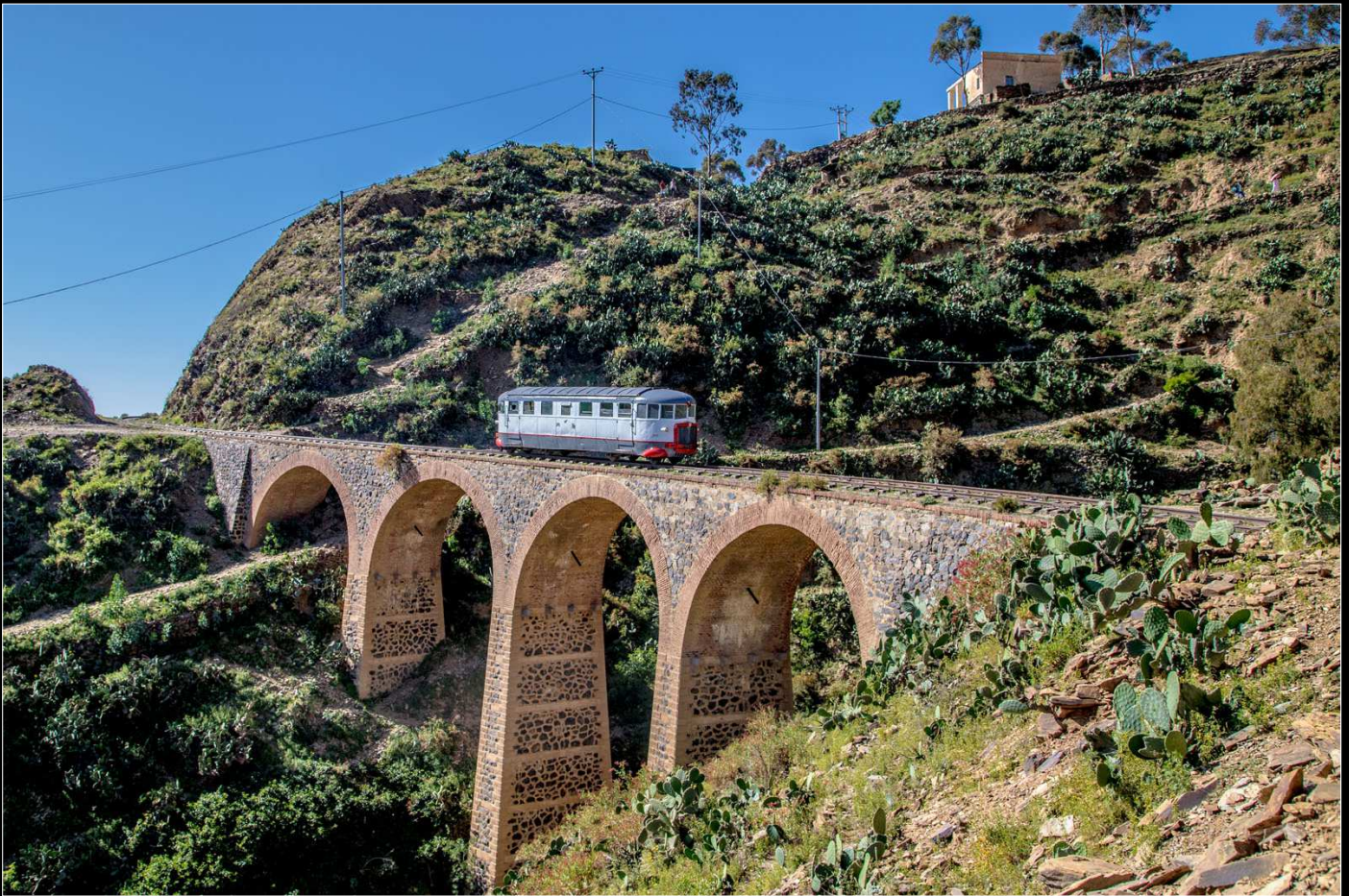
Auf dem großen Viadukt wirkt die Littorina etwas verloren.
